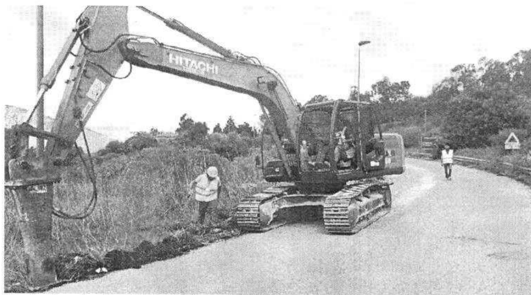
I lavori per la realizzazione della bretella alternativa all'autostrada Palermo-Catania
