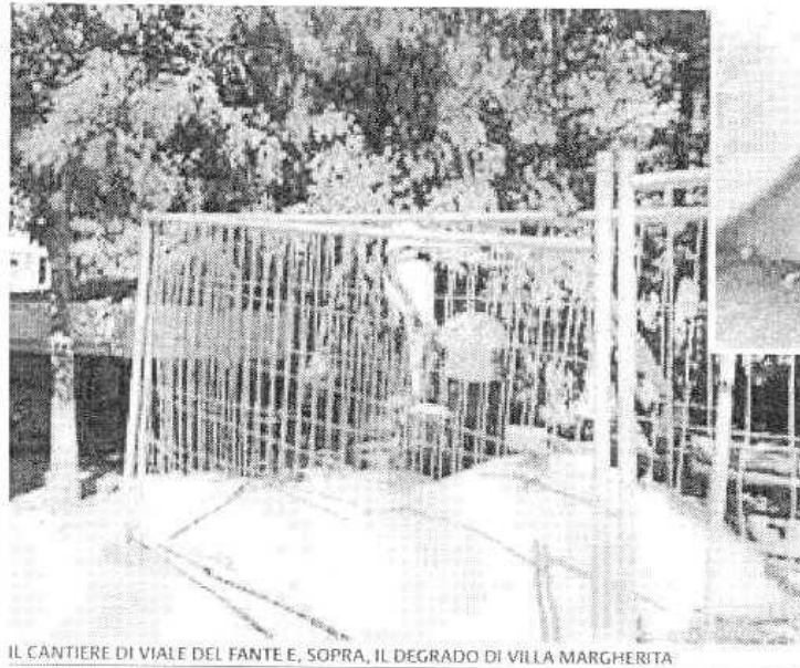
IL CANTIERE DI VIALE DEL FANTE E, SOPRA, IL DEGRADO DI VILLA MARGHERITA
